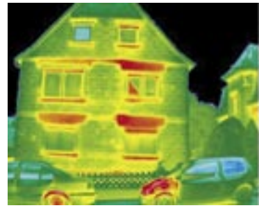
隔热不良造成的热点
