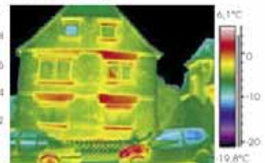
隔热不良引起的热点
